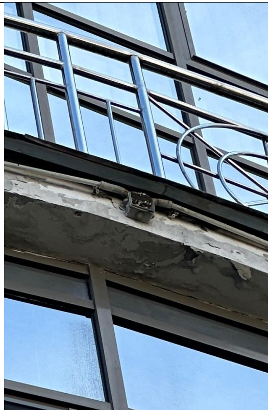
Фото 5. Вид дефектов фасада в виде отслоения штукатурки на откосах и балконах
