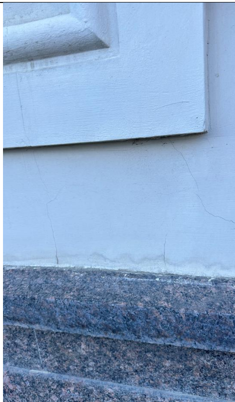
Фото 7. Виды дефектов фасада в виде отслоения и трещин штукатурки.
