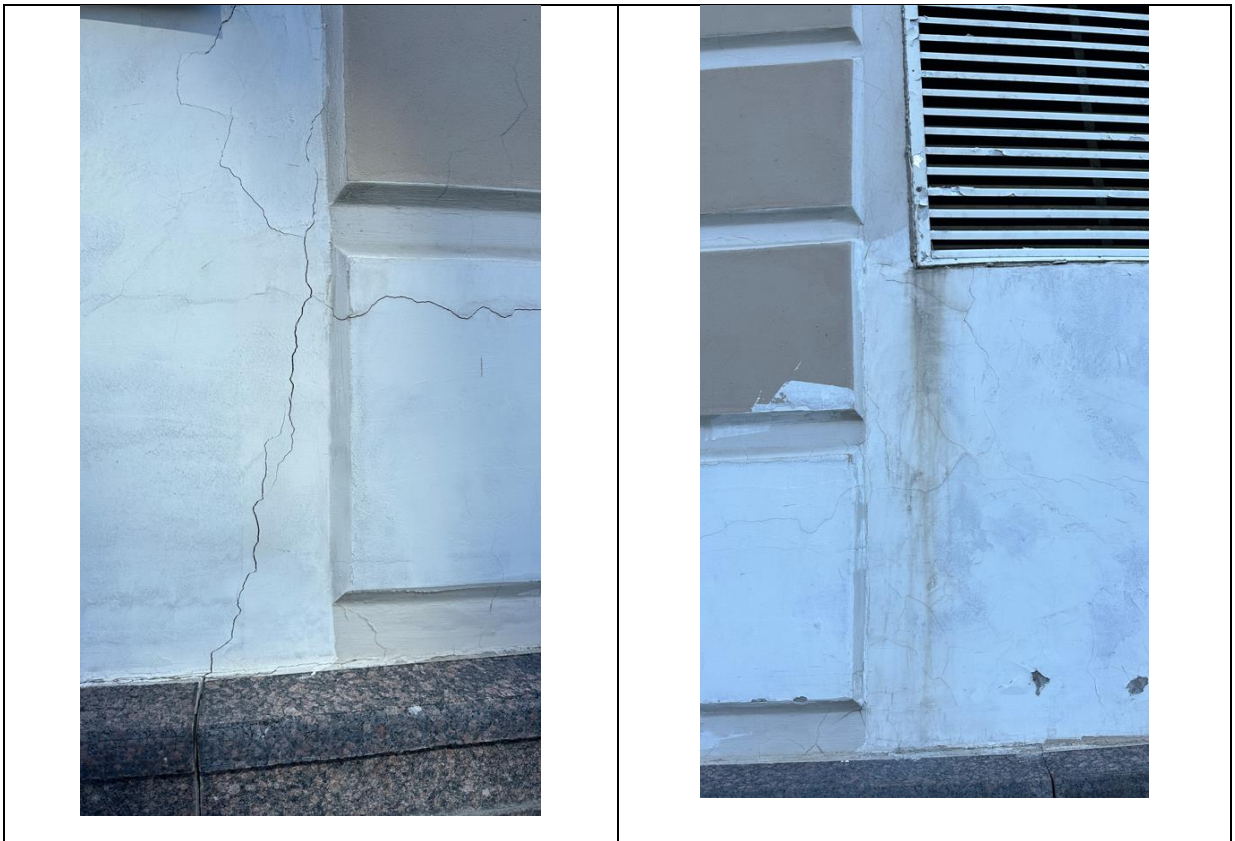
Фото 8. Общий вид условной части №3 западной стороны фасада здания и дефекты в виде растрескивания штукатурки и окраски на фасаде, откосах и балконах
