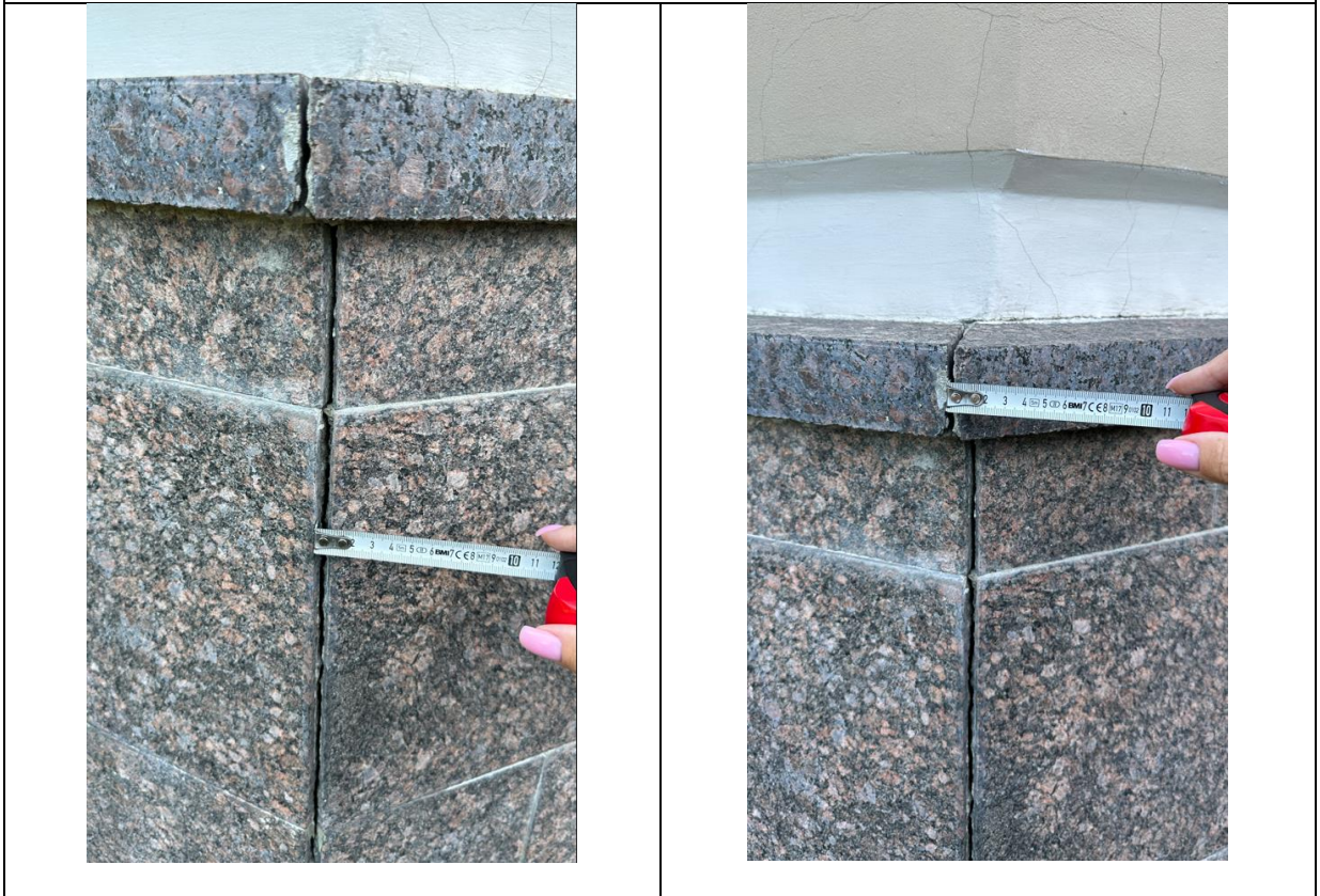
Фото 6. Виды дефектов фасада в виде отслоения плит натурального камня.
