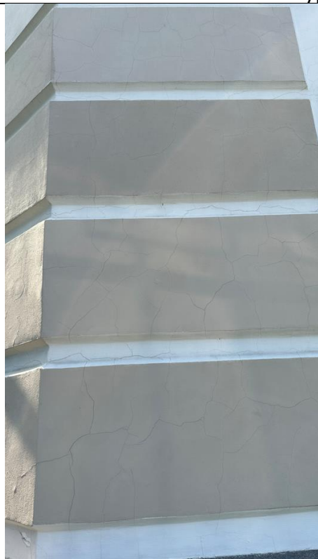
Фото 3. Виды дефектов фасада в виде трещин по краске, штукатурке и облицовке натуральным камнем.
