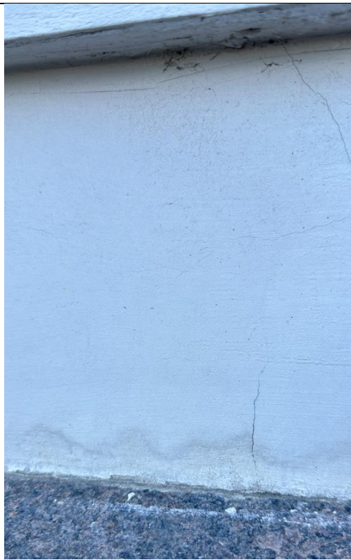
Фото 7. Виды дефектов фасада в виде отслоения и трещин штукатурки.
