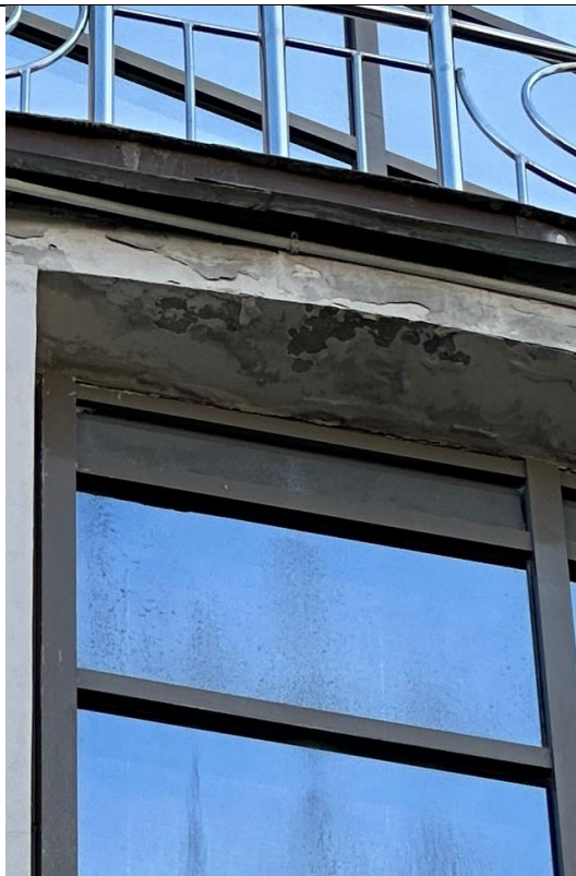
Фото 5. Вид дефектов фасада в виде отслоения штукатурки на откосах и балконах
