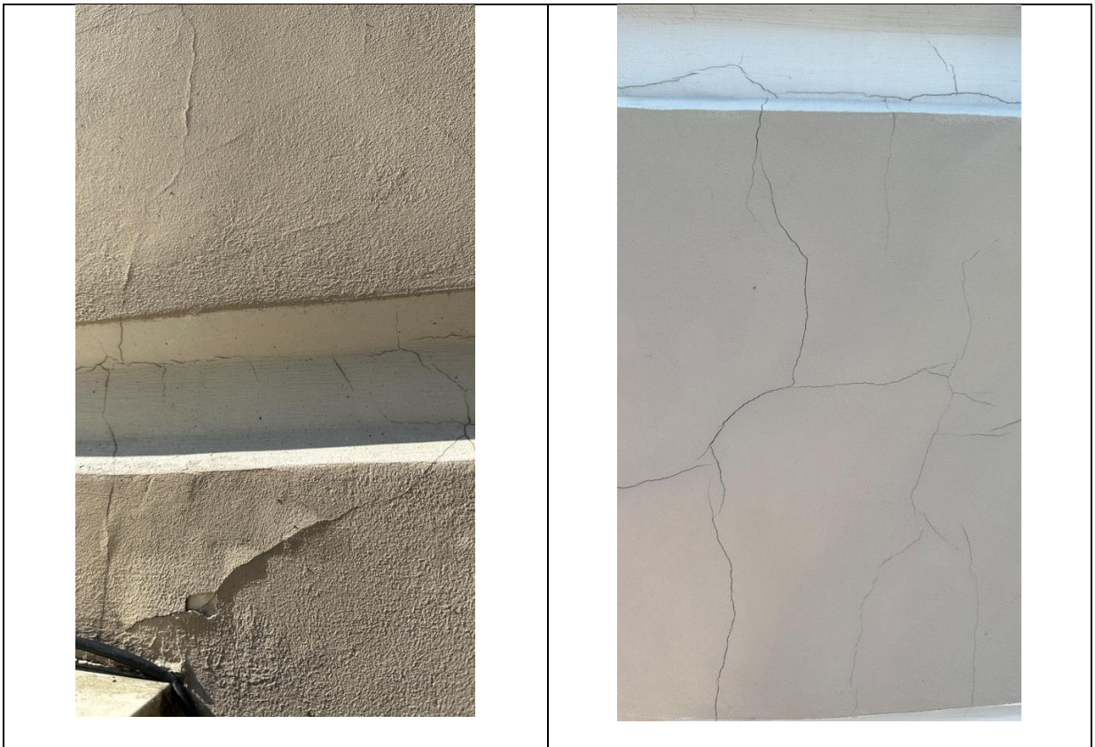
Фото 4. Общий вид условной части №2 северо-западной стороны фасада здания и дефекты в виде растрескивания штукатурки и окраски
