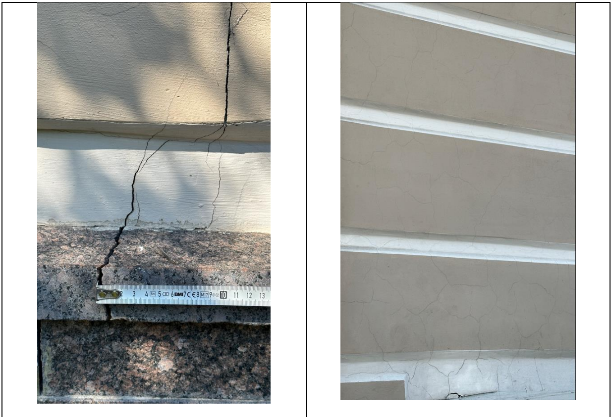
Фото 11. Общий вид дворовой части фасада здания и дефекты в виде растрескивания штукатурки и окраски на фасаде, откосах и балконах
